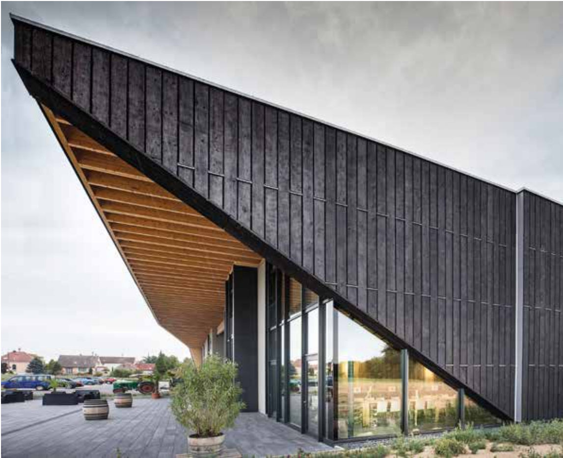
Weingut Nett, Eingangsbereich, Neustadt an der Weinstraße (DE) Foto: Rui Camilo/Architects Collective ZT-GmbH
