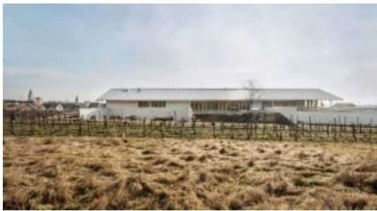
Das Bio-Weingut der Familie Gruber in der Kellergasse in Röschitz. © Hertha Hurnaus
