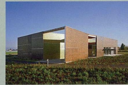
Die Konstruktion | Ein Holzskelettbau aus Leimbändern im Abstand von fünf Metern trägt „Isoboxen“ (OSB-Platten beidseitig, dazwischen Mineraldämmwolle) verschiedener Größe: Die Stapelung der 5 x 2,5 Meter und 5 x 1,5 Meter großen Module ist an den Kanten der Traufbleche ablesbar.
