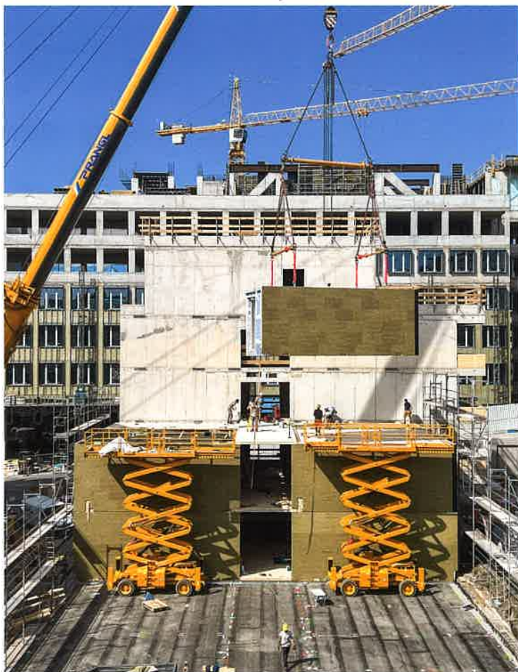
Einheben eines vorgefertigten Holzmoduls auf der Baustelle des AKH Wien und fertige Raummodule im steirischen Werk, bereit für den Transport. Lifting a prefabricated timber module onto the construction site of the AKH Vienna and room modules at the Styrian factory, ready for transport.
