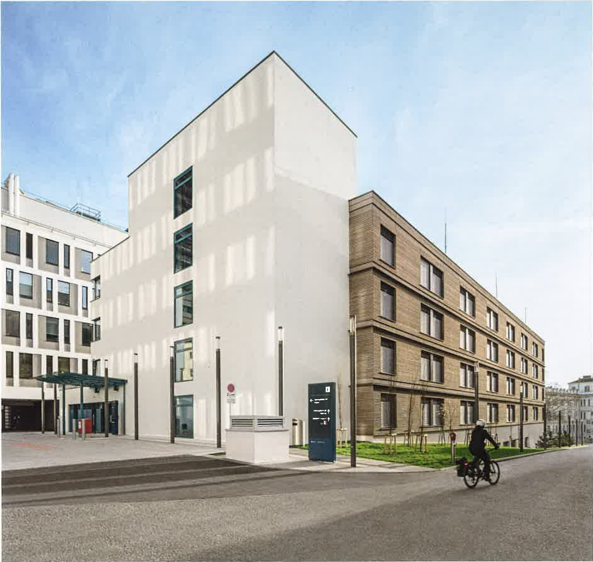
Außenansicht des Stationsgebäude Süd am AKH Wien mit vorgegrauter Lärchenholzfassade neben dem Bestandsbau. Exterior view of the South Ward Block at Vienna General Hospital, with its pre-grayed larch timber facade, next to the existing building.
