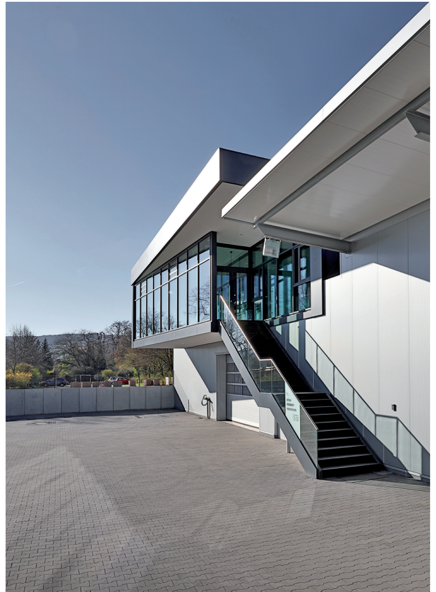
Hauptzugangstreppe Main access stairway
