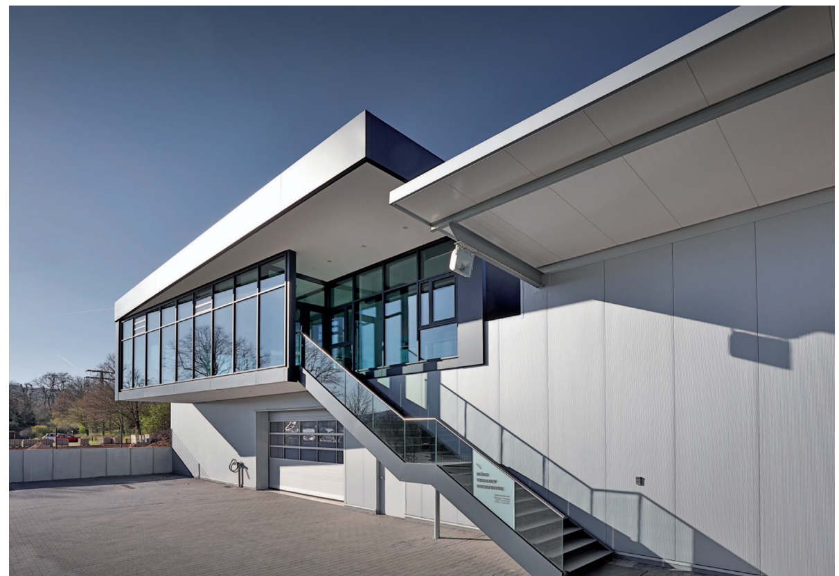
Hauptzugangstreppe Main access stairway
