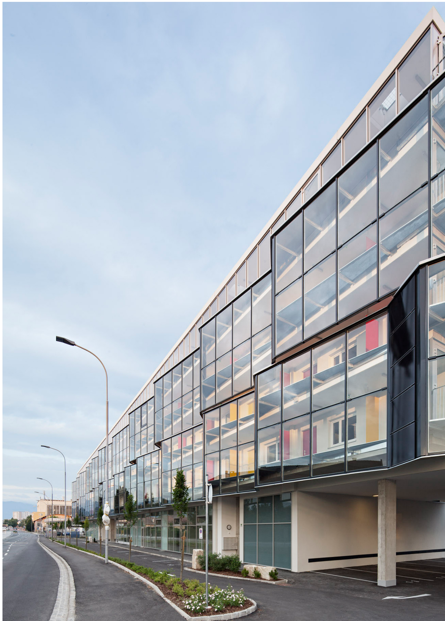
Straßenansicht View from the street
