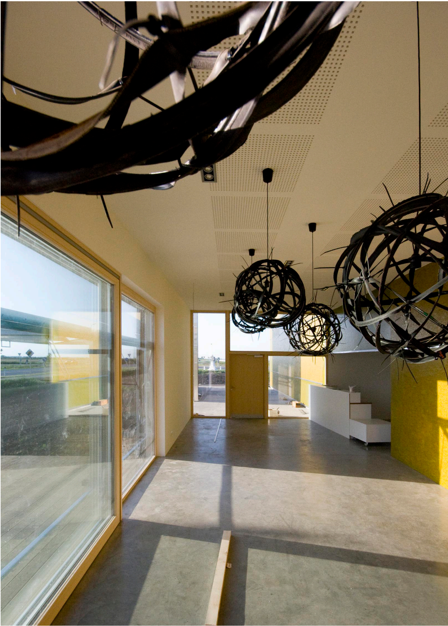
Shop (noch im Bau) Shop (under construction)
